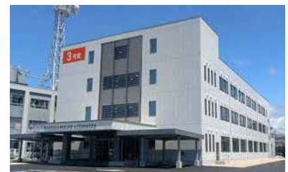
【西部総合事務所3号館】
